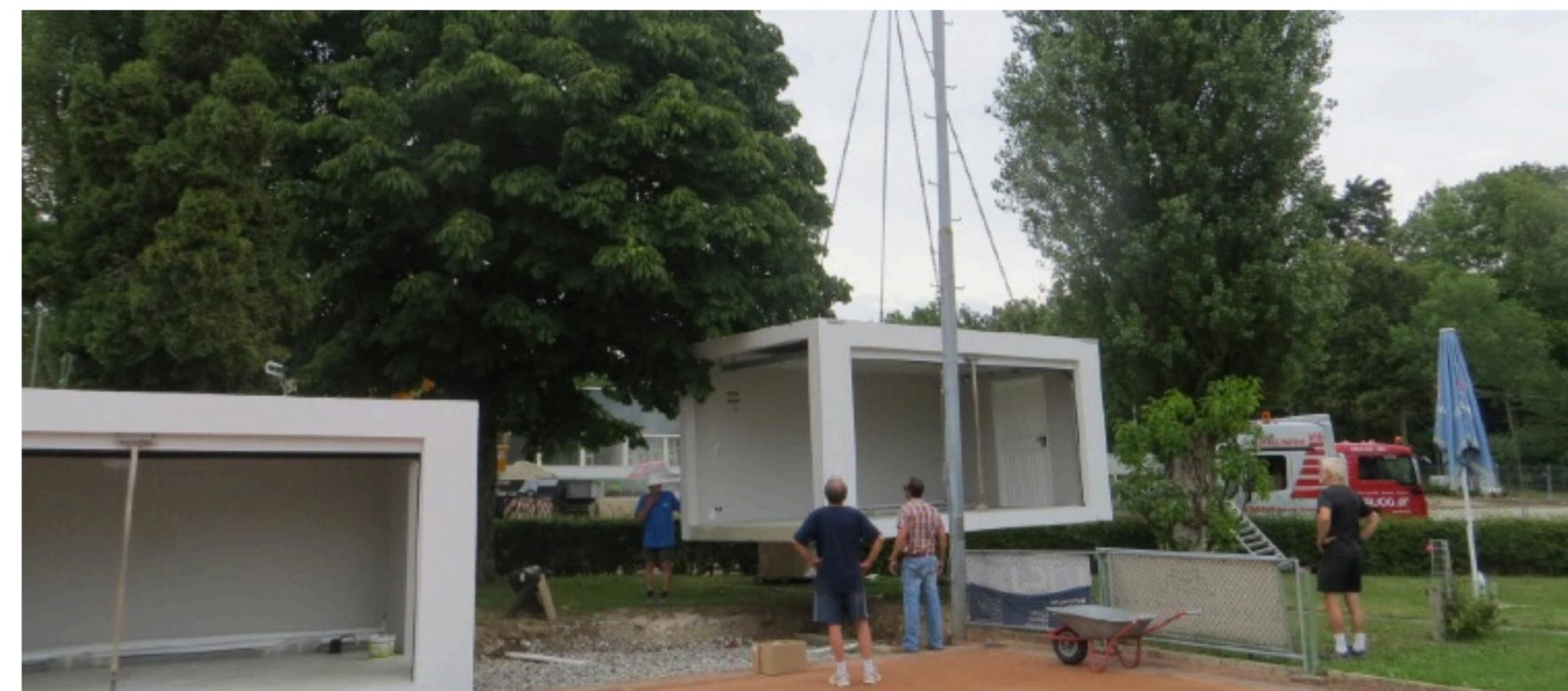
Unter dem Hangar befindet sich ein Sickerbett. Die Garagen werden millimetergenau auf die schwarzen Klötzchen aus Hartkunststoff gestellt.
