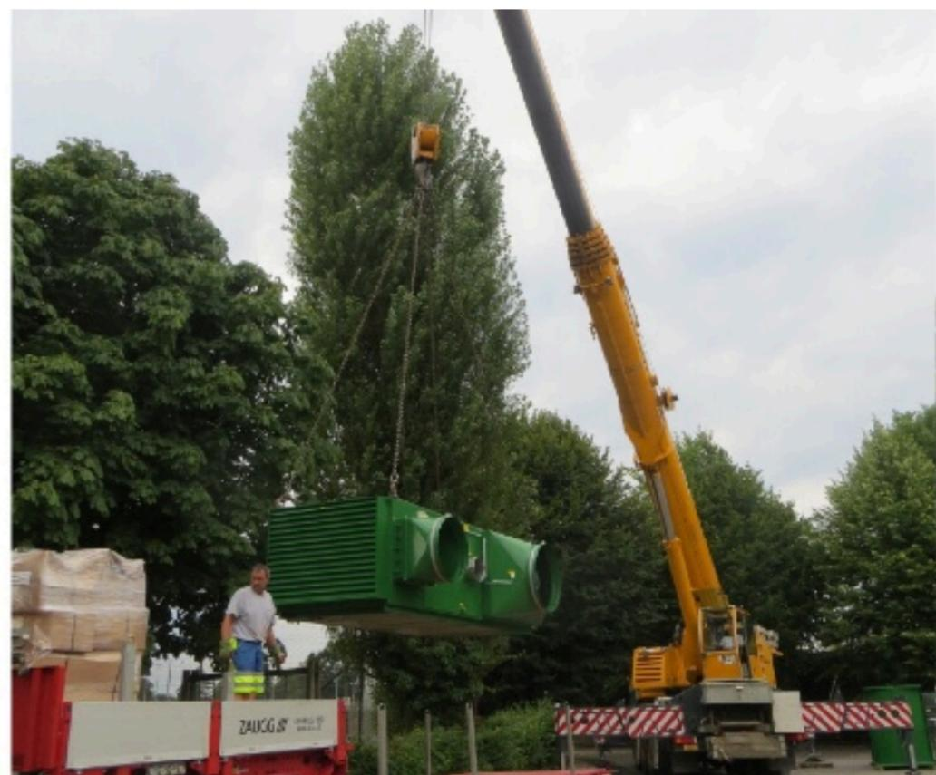
Juli 2015: Nun ist es soweit! Der Hangar, bestehend aus 3 Fertigaragen (je 33 Tonnen), und das Aggregat werden geliefert. Der 110-Tonnen-Kran hievt die 4 Teile zwischen den Bäumen hindurch auf das bereit stehende Fundament.
